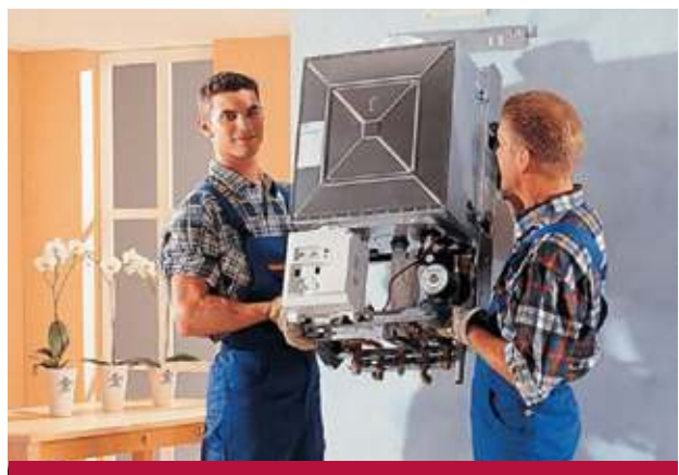
... bis zur Inbetriebnahme der neuen Erdgasheizung.
