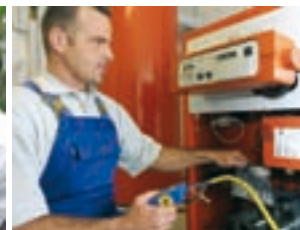
Betrieb und Service
